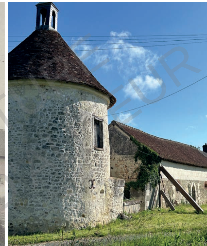
Photo de l'abri aujourd'hui avec la jambe de force en bois (document personnel)
