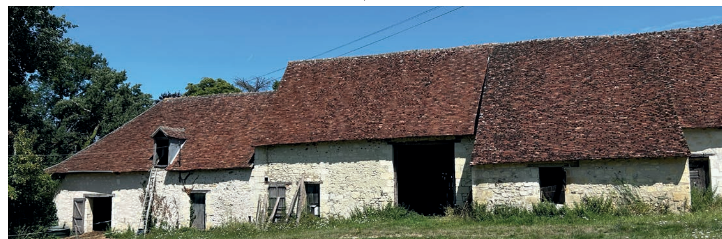
Photo façade ouest de la ferme de la Moustière (F3 et F4)
