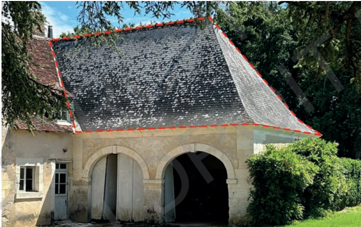
Photos de la différence de dimension de la toiture, couverture en ardoise des dépendances (D2) (document personnel)
