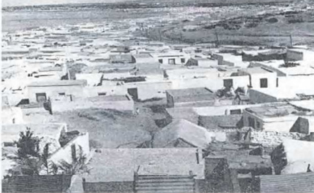
Vue sur le gourbiville de Saïda Manoubia. A partir des années 1940, les constructions se sont multipliées jusqu'aux abords de la sebkha sijoumi sur des parcelles immatriculées.
