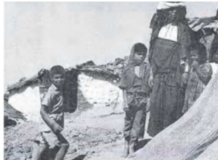
Gourbi traditionnel avec murs en toub (mélange de terre et de paille malaxées) et toit en tôle
