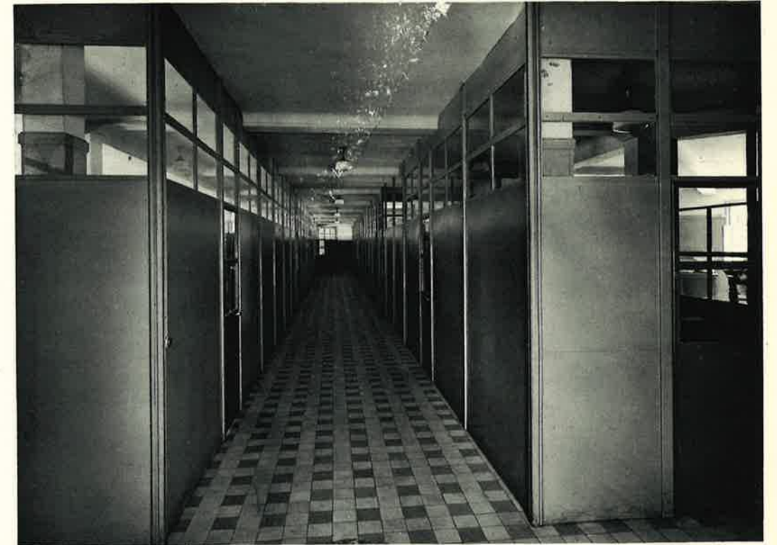
Building Revillon. MM. GRANDPIERRE & PIQUART, architectes ; PROUVE, constructeur.
