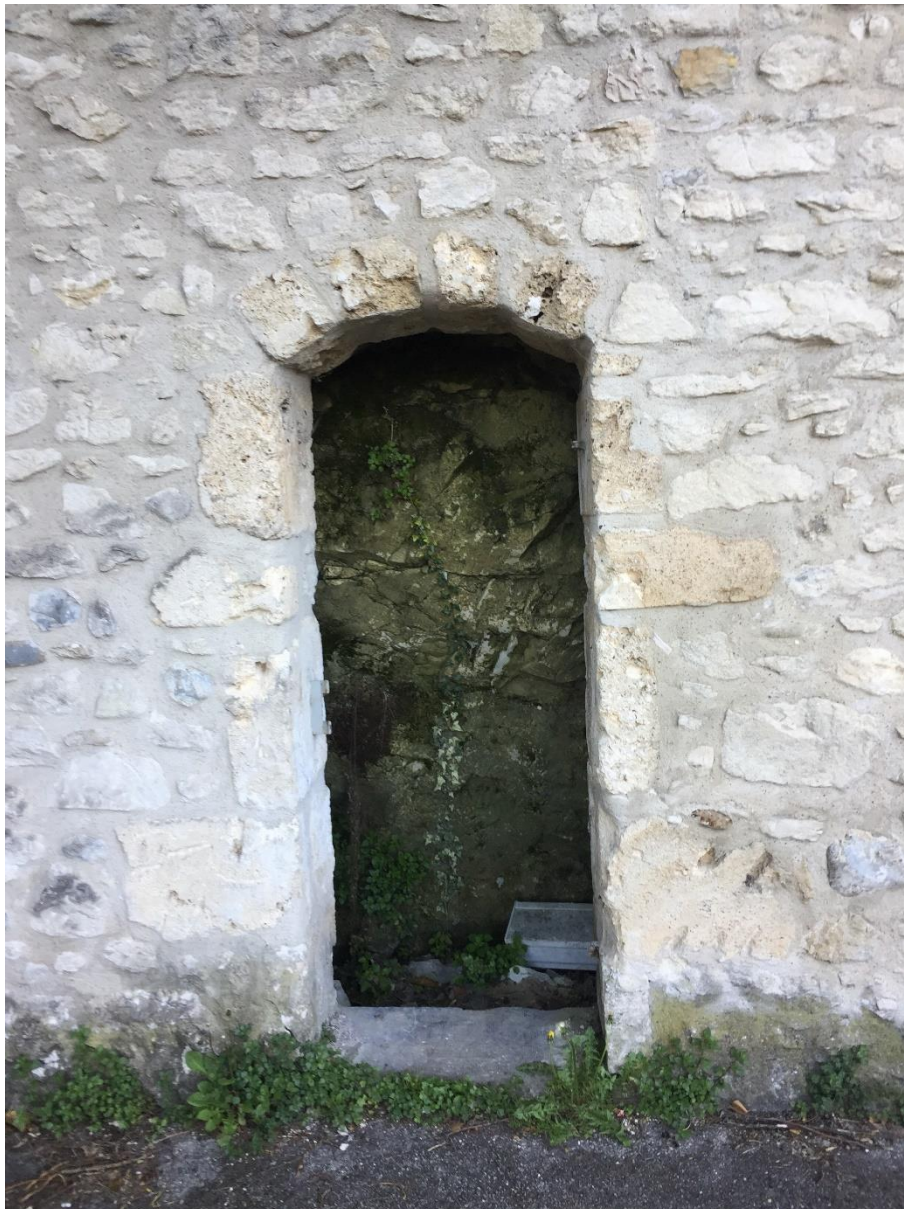
Ouverture en molasse dans mur ancien
