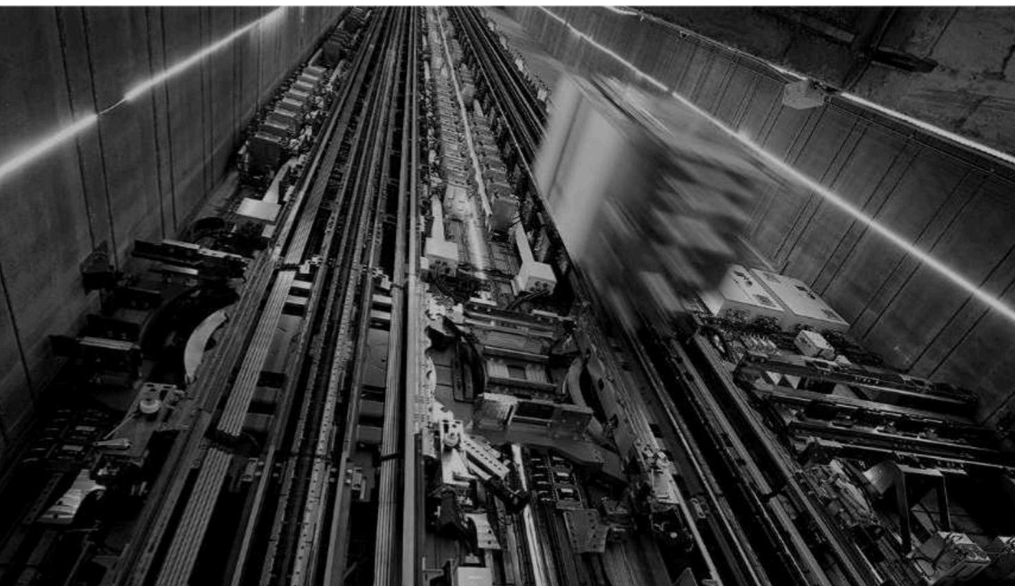
Figure IIB2-1 / Intérieur d'une gaine dans laquelle est mise en place le système MULTI.
