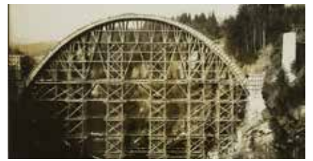
Échafaudages Gmündertobelbrücke , Suisse - R. Coray (1907-08). Malgré leur éphémérité, les structures d'échafaudages sont, dans certains cas, de véritables prouesses techniques, et constituent un architecture à part entière.
