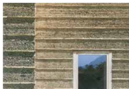
Ci-dessus : Mur de pisé de la maison Rauch. Le constructeur ne protège pas la façade par un débord de toiture important, les lits de tuiles en terre cuite sont une manière alternative de s'opposer à l'érosion de la façade.
