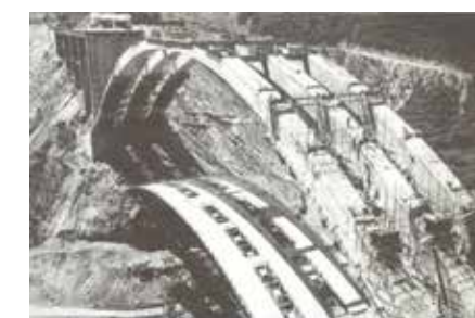
L'arc après le décoffrage.
