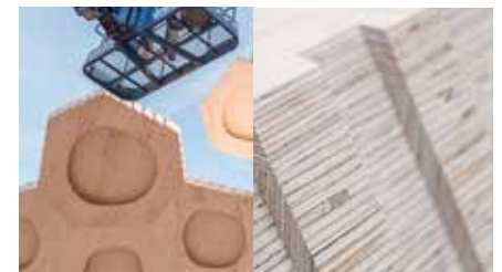
Ci-dessus, à gauche : assemblage des plaques de bois les unes aux autres. À gauche : Joints liants les plaques.
