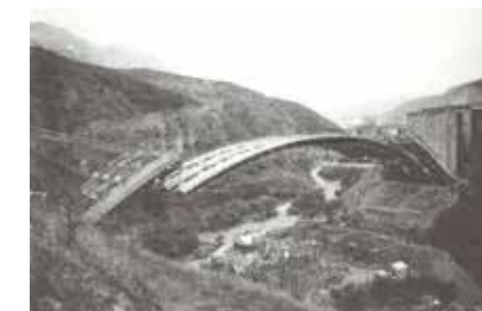
Montage de la partie centrale du cintre, construite grâce à la précontrainte.
