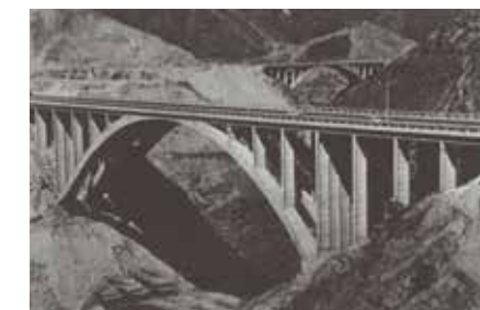
Eugène Freyssinet. Viaducs pour l'autoroute de Caracas à La Guaira, 150m de portée, 60m de hauteur. 1951-1953.
