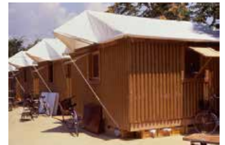
Paper-log Houses à Kobe, (Japon) Shigeru Ban (1995)
