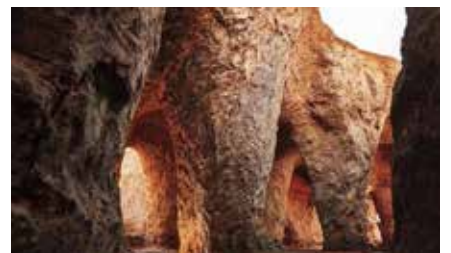
Restaurant Noel (Yamaguchi, Japon) - Junya Ishigami. En creusant dans le site du projet, l'architecte détourne la terre est en un coffrage pour le béton.
